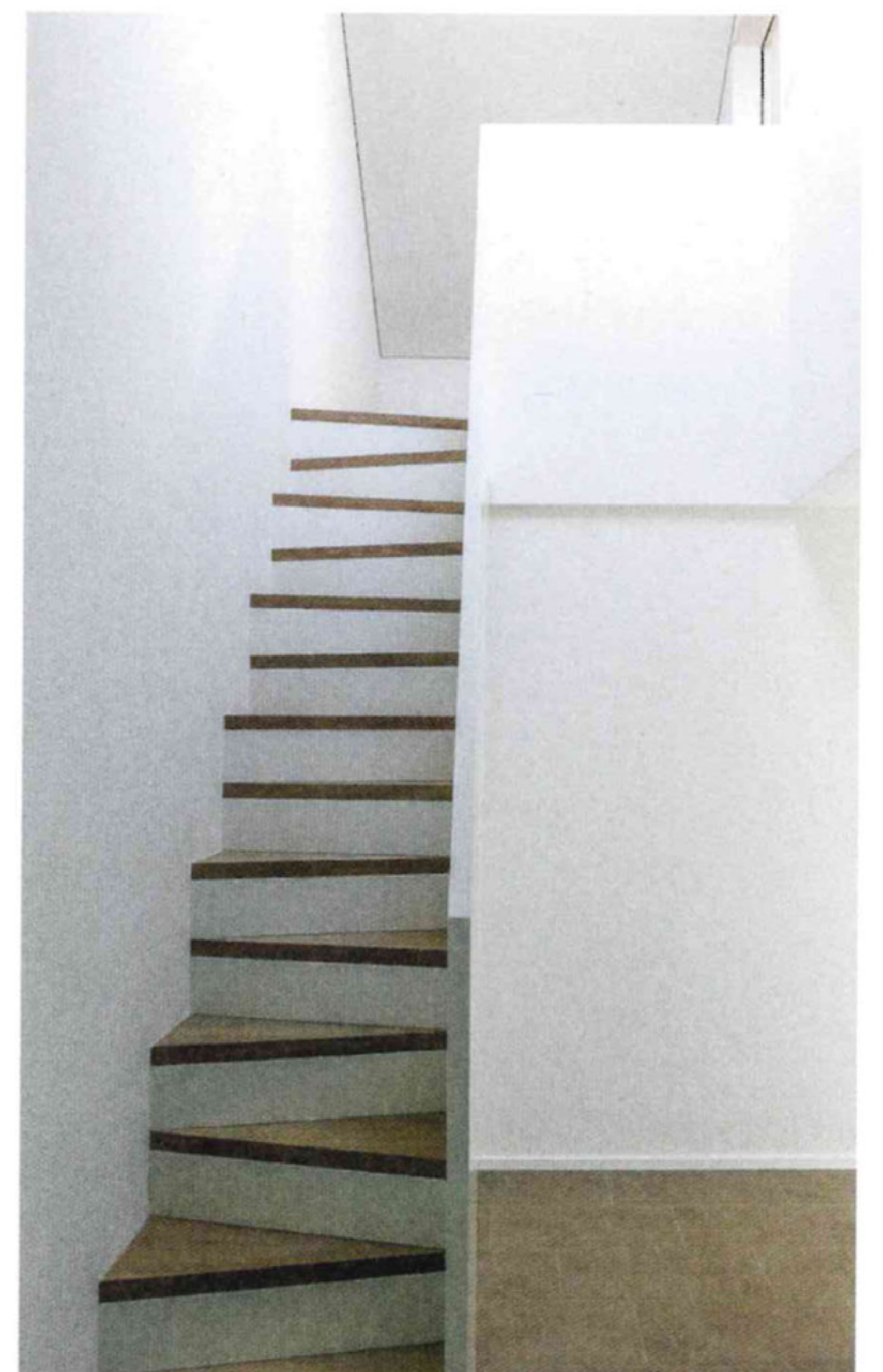
En bas: L'escalier à pas japonais permet une montée sur la galerie.
